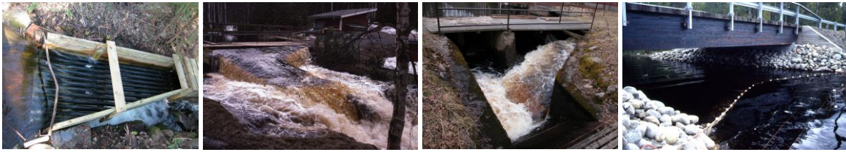
Kuva 6. Ruuhiojan ankeriasarkun muoviputkista rakennettu välppä, Majakosken arkku välppä lehtien tukkimana ja puhtaana tulvassa sekä oikealla Evojoen pohjapadon päälle asennettu havasohjain ja rysä.
