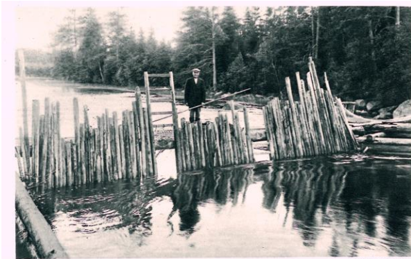
Kuva 141. Ruotsin-Pyhtää, Ahvenkoski. Kaksiaukkoinen ankeriaspato Lanakoskessa. Tekijä valok. 1920.
