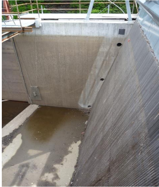
Kuva 10. Pystyvälvät Emån-joella Ruotsissa (vas) ja Alster-joella Saksassa. Pakoaukot pohjan tuntumassa tai puolivälissä toimivat ankeriaalla paremmin kuin pinnassa olevat pakokanavat.
