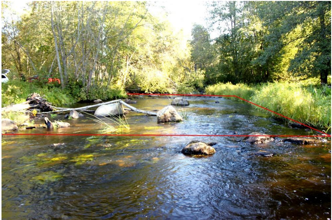
Kuva 17. Tehtaankoski Hauenkuono pääuoma (kuva: Tapio Mäkelä)
