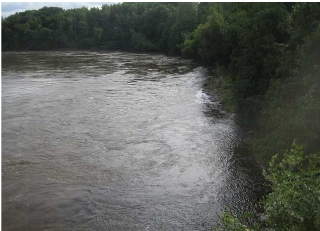
Kuva 19. Arantilankosken vuonna 2002 kunnostettu alue, kun virtaama on noin 240 m 3 /s.
