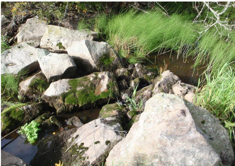
Kuva 12. Pisteessä P10 olevaa kivipatoa avataan keskeltä hieman siirtämällä kiviä, jotta veden virtaus uomassa säilyy alivirtaamien aikanakin.
