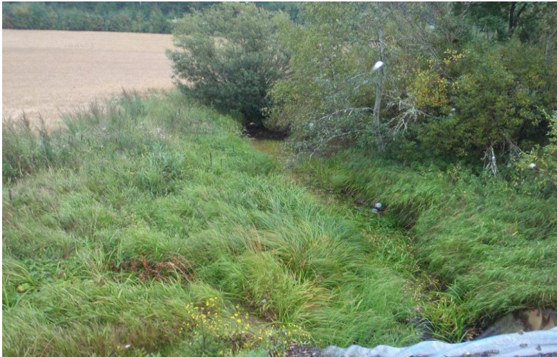
Kuva 4. Luojoki P10 Nevontieltä kuvattu. Vesikasvisto niitetään ja poistetaan uomasta.
