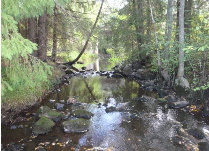
Kuva 11. P1 + 30 ylöspäin uoma kivetään hieman ja alaosassa olevaa soraikkoo putsataan ja kuohkeutetaan.
