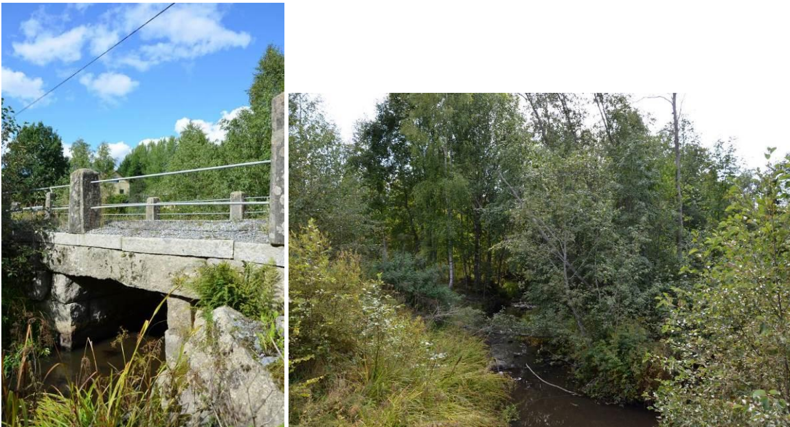
Kuva 18 (Kuvat). Vas. Vanhaan Kikkerlängtien yksiaukkoinen kivisilta on rakennettu suorista lohkotuista kivistä kylmämuuraamalla. Sillan yläosassa on käytetty paremmin käsiteltyä kiveä ja kaiteiden pylväiden kulmat on hienohakattu. Oik. Sillan kupeeseen v. 1907 karttaan merkitystä myllystä ei löytynyt näkyviä jäänteitä.
