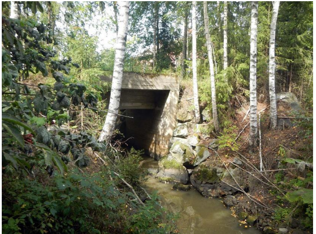
Kuva 7. Kikkelän joen ylittävä silta Eskon talon kohdalla. Joen muokkaus ja betonisillan rakentaminen on muokannut uomaa merkittävästi. Myllynjäänöksiä ei havaittu.
