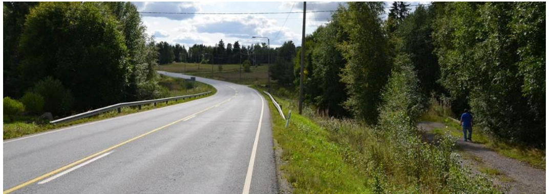
Kuva 15. vasemmalla uusi ja oikealla vanha tie siltoineen pohjoisesta kuvattuna.
