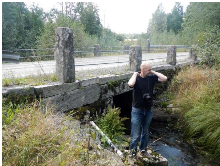
Kuva 15. Myllyharjun silta on tehty lohkokivistä.
