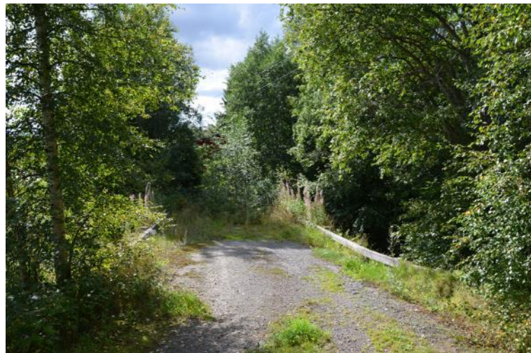
Kuva 3. Vakkalan vanha silta ei ole enää käytössä.
