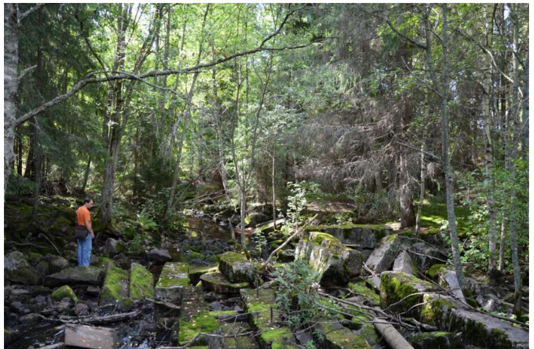
Kuva 23. Horilan myllyyn liittyviä näyttäviä rakenteita.
