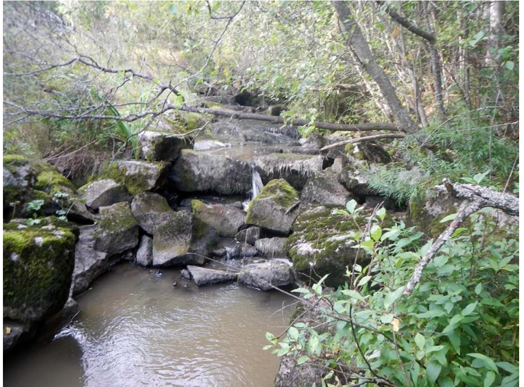
Kuva 32. Raukon mylly. Jokiuoman lohkokivisiä kivrakenteita.
