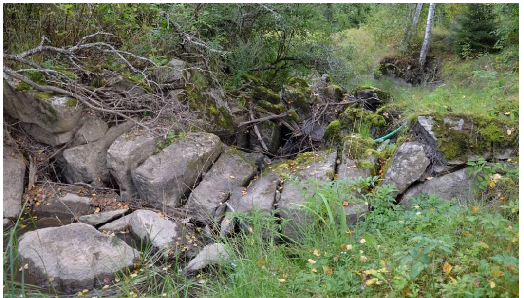
Kuva 23. P15 Lohkokivistä rakennetun, holvattun kaarisillan jäänteet länsipuolelta kuvattuna.
