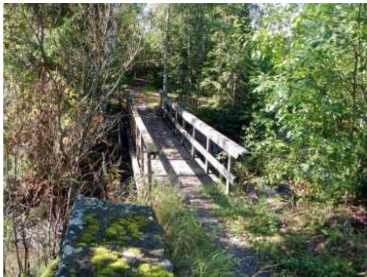
Kuva 18. Nykyinen silta on puinen kevyenliikenteen väylän silta.
