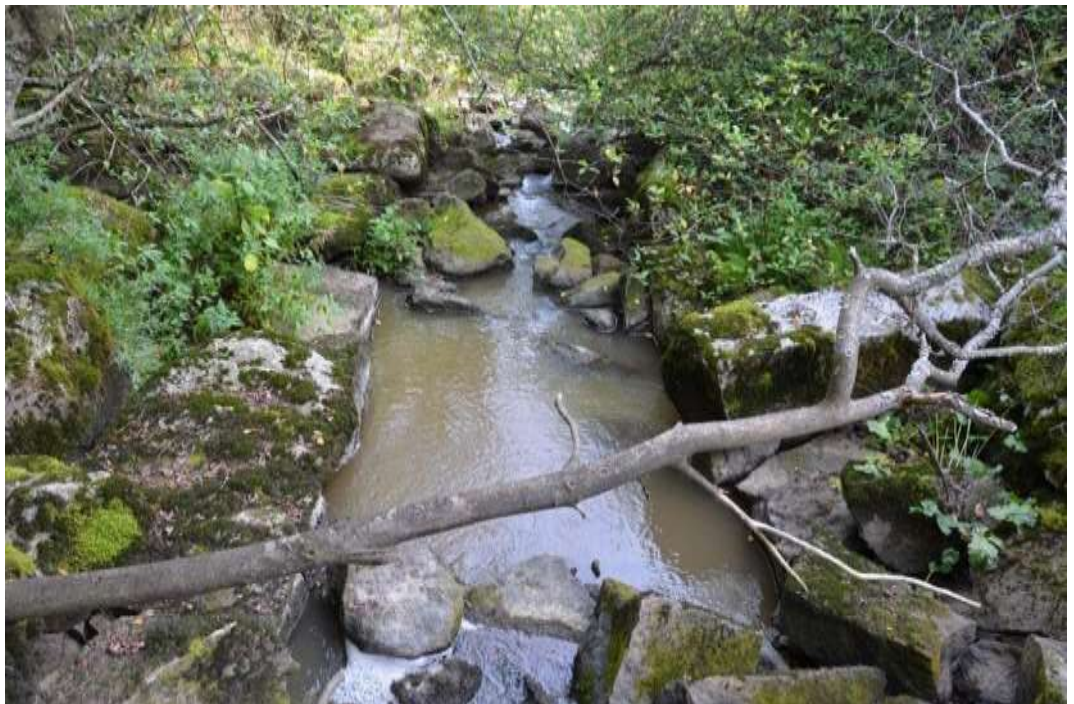
Kuva 33. . Raukon mylly. Jokiuoman lohkokivisiä kivirakenteita.
