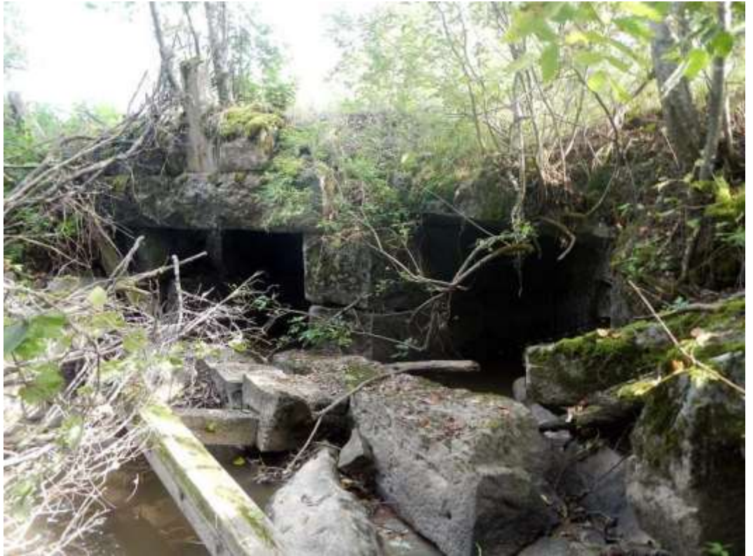
Kuva 29. Raukon kaksiaukkoisen sillan raunio. Etualla sillasta pudonneita kiviä.
