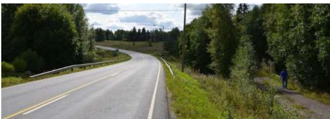
Kuva 15. vasemmalla uusi ja oikealla vanha tie siltoineen pohjoisesta kuvattuna.
