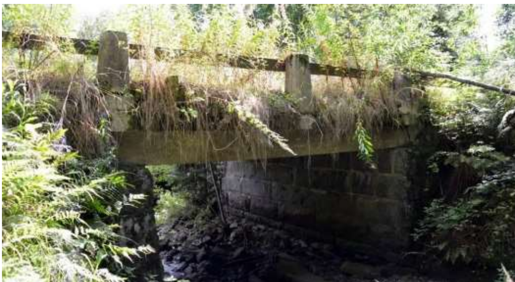
Kuva 14. Nykyisen Pohjanmaantien sillan luoteispuolella on vanhempaan tielinjaukseen liittyvä, käytöstä poistunut silta, jonka maatuet ovat muurattu lohkokivistä, sillan kansi ja kaiteiden pylväät ovat betonivalua, kaiteet puuta.
