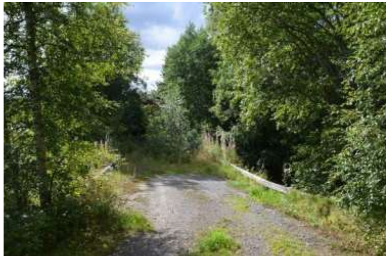
Kuva 3. Vakkalan vanha silta ei ole enää käytössä.
