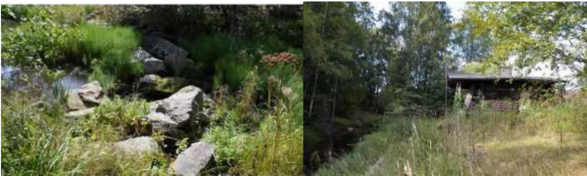
Kuva 10. Kuvat: Kivipato ja huvilarakennus.
