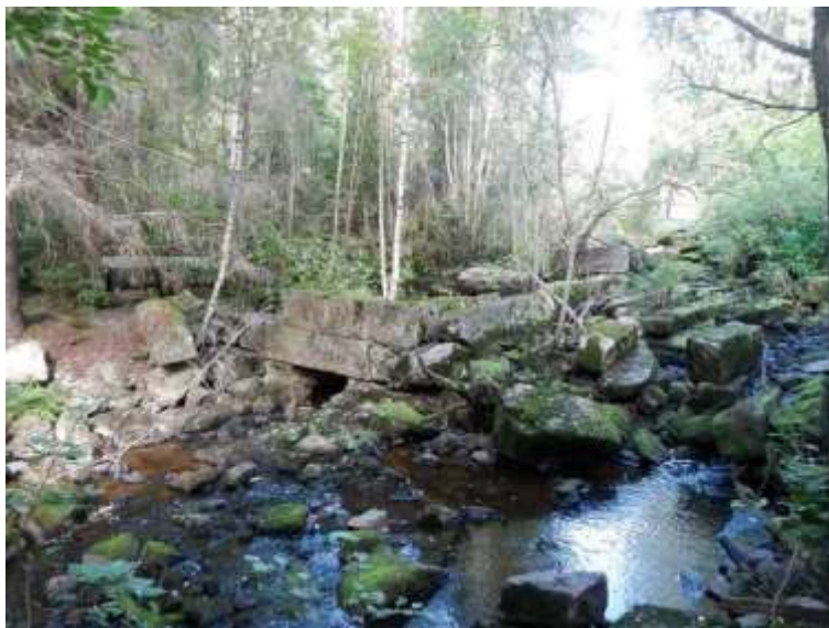
Kuva 24. Horilan myllyrakennuksen raunio.
