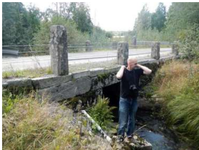
Kuva 15. Myllyharjun silta on tehty lohkokivistä.
