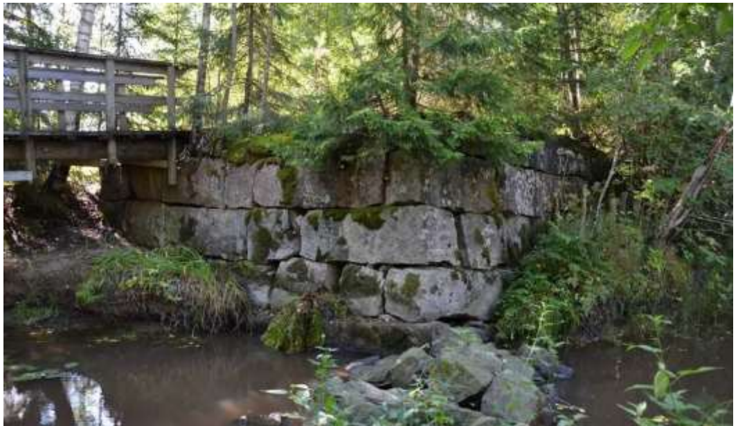
Kuva 4. Laidetien sillan lohkokivistä rakennettu pitkä pengeri ja nykyinen kevyen liikenteen puusilta. Etualalla näkyy joen virtauksen hidastamiseksi tehty nuorehko kivipato. Sillan kivrakenteiden läheisyydessä kasvava puusto olisi hyvä poistaa rakenteen säilymisen turvaamiseksi. Kuva otettu joen pohjoispuolelta.
