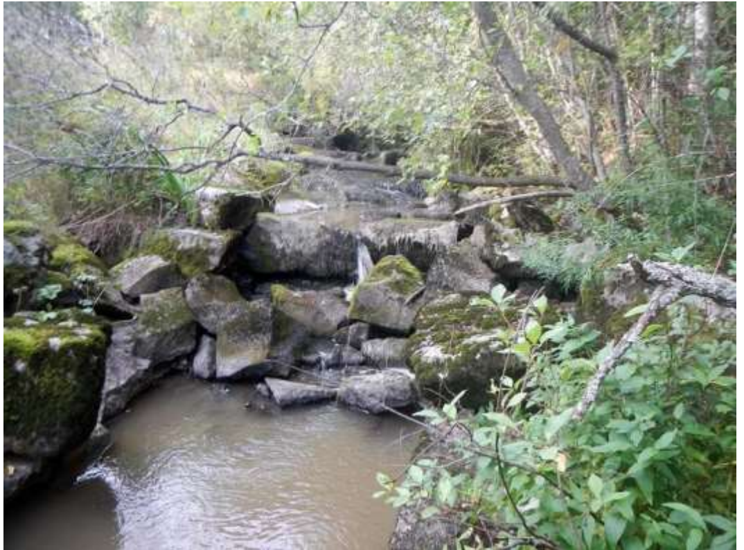
Kuva 32. Raukon mylly. Jokiuoman lohkokivisiä kivirakenteita.
