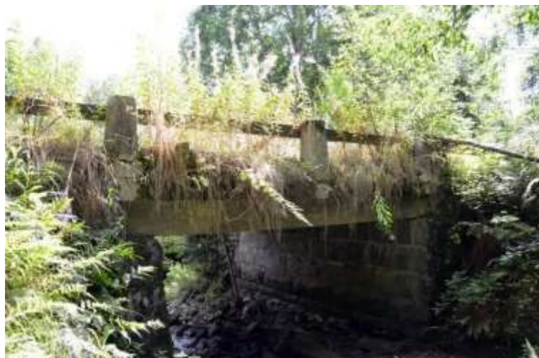
Kuva 4. Vakkalan silta. Kuva: Kalle Luoto.
