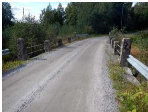
Kuva 14. Myllyharjun silta on käytössä oleva tie.
