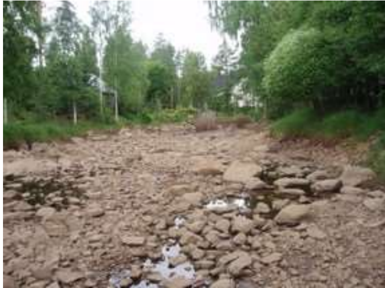
Kuva 75. Sonnilanjoki, Kosken pato ja lähes kuivillaan oleva patoallas
