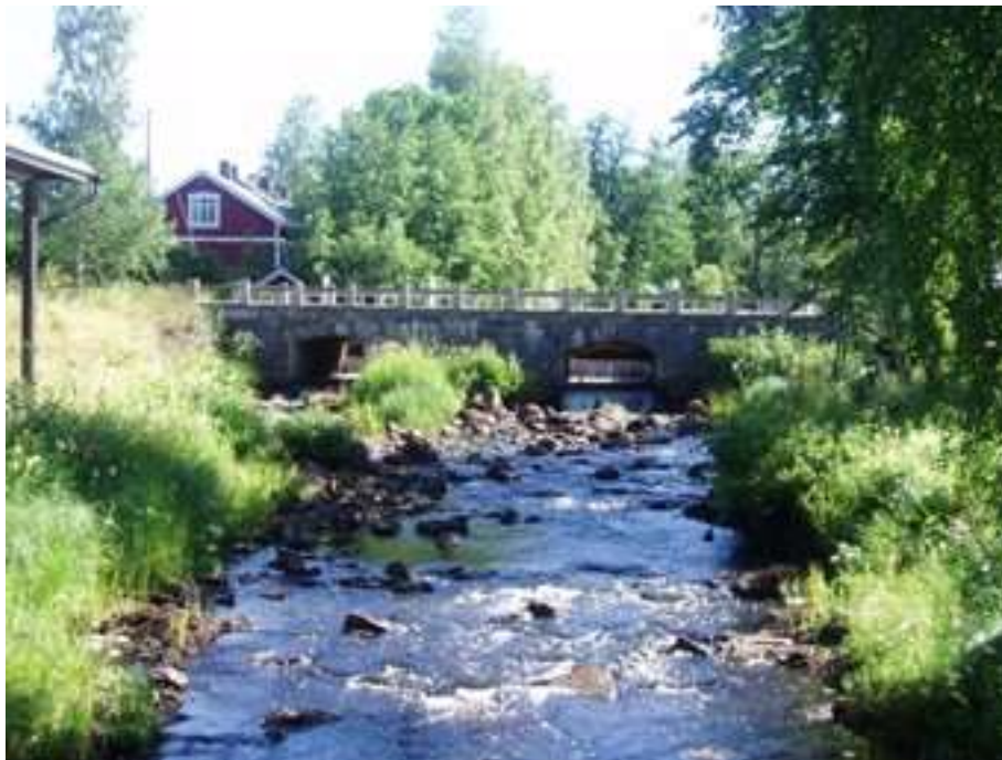
Kuva 49. Harjunpäänjoki, Leineperin Pajakosken säännöstelypato
