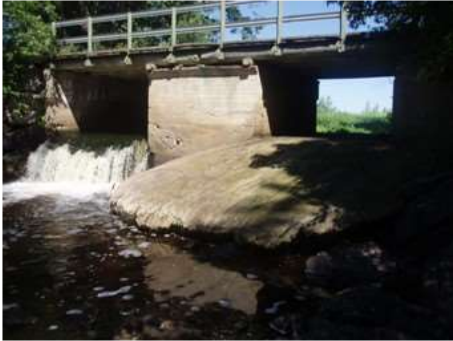
Kuva 46. Harjunpäänjoki, Solakosken pato
