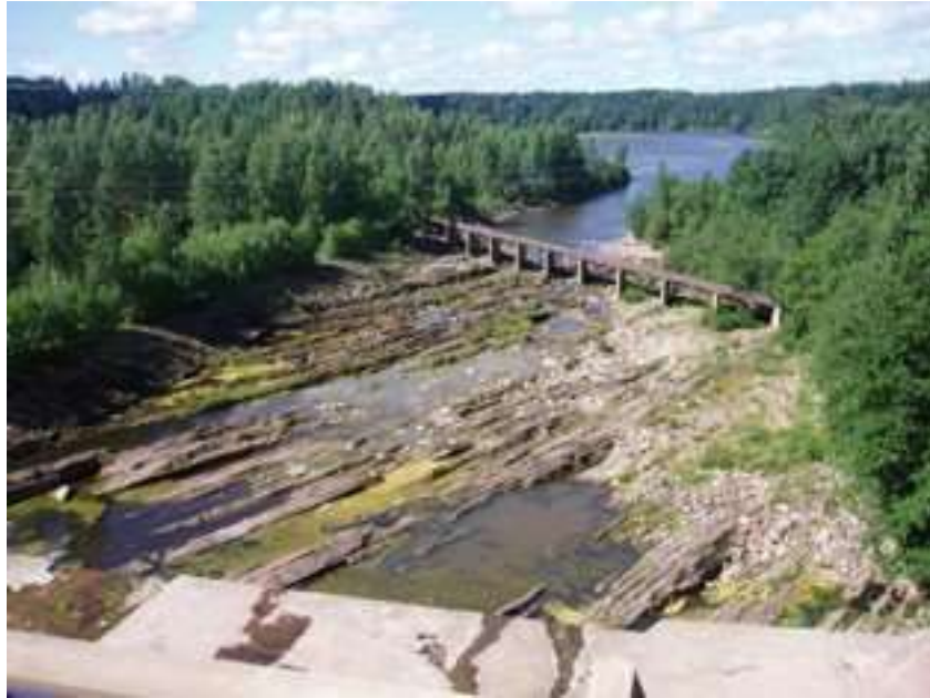
Kuva 2. Näkymä Harjavallan voimalaitospadolta
