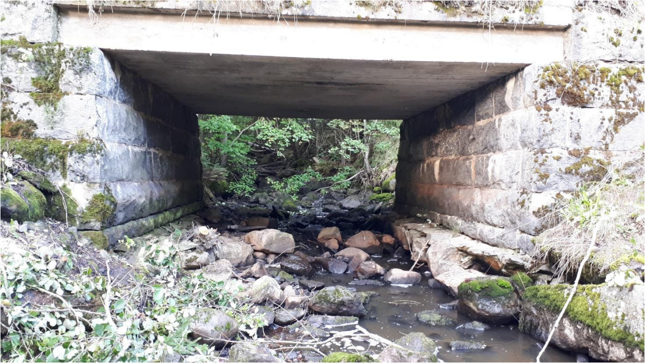
Kuva 3.6. Vakkalan koealan lähtöpiste Pohjanmaan tien alla 13. syyskuuta 2019
